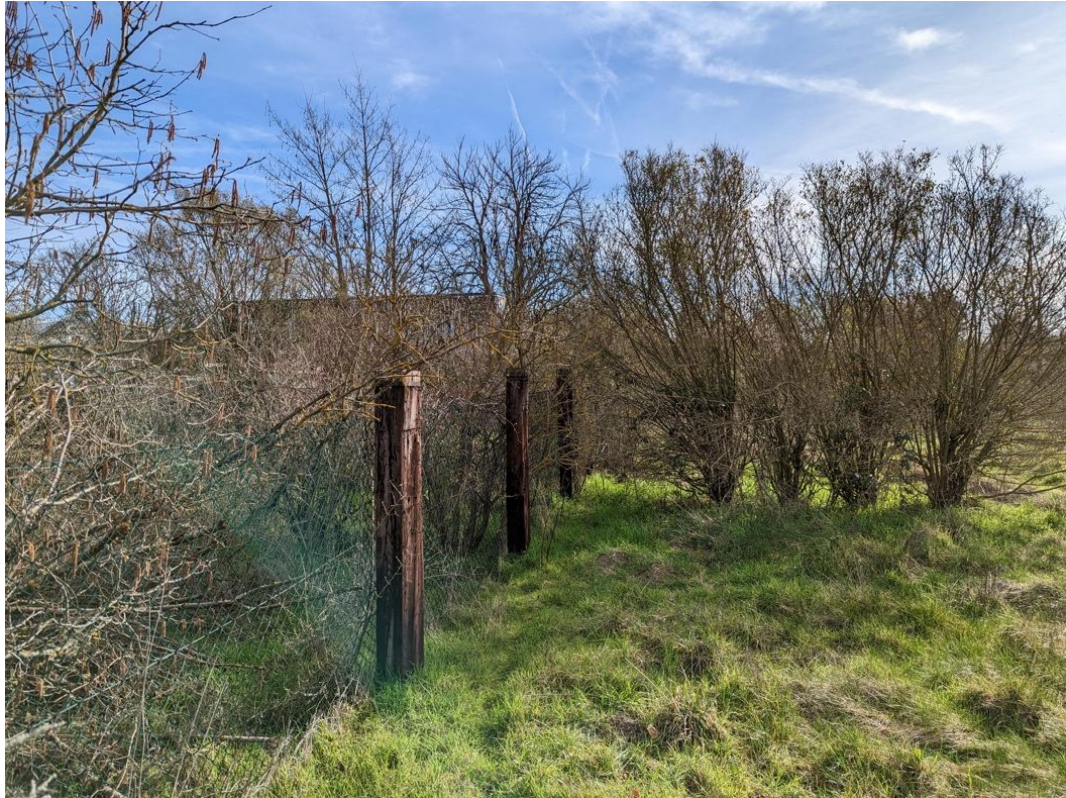
Foto: Einfriedungen mit teerölhaltigen Bahnschwellen
